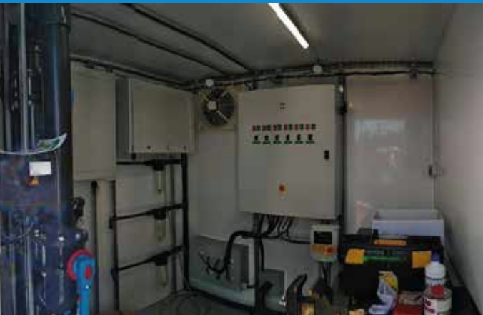
Container avec deux armoires de dosage FeCl3 et Flocculant
