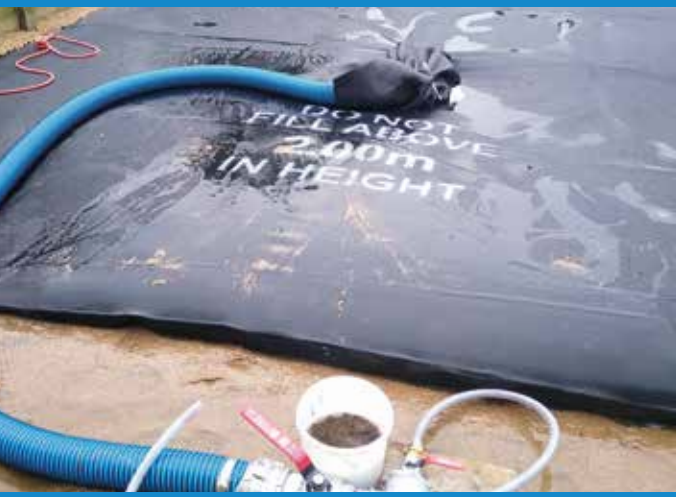
Essorage sur TenCateGéotube®
